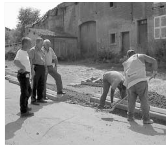
Les élus et le chef de chantier, satisfaits des travaux en cours.
